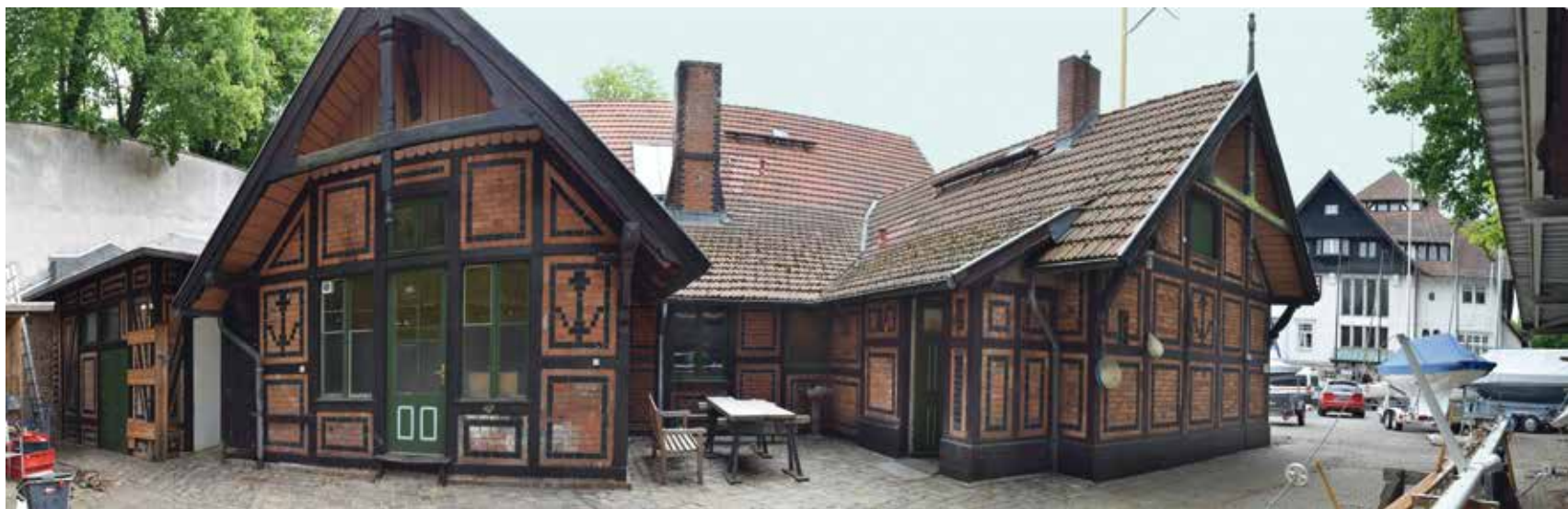
Oben: Giebelansicht 1909 von der Straße auf das alte Seglerhaus. Unten: Giebelansicht Ende Juni 2018 auf das alte Seglerhaus, vor der Sanierung.
