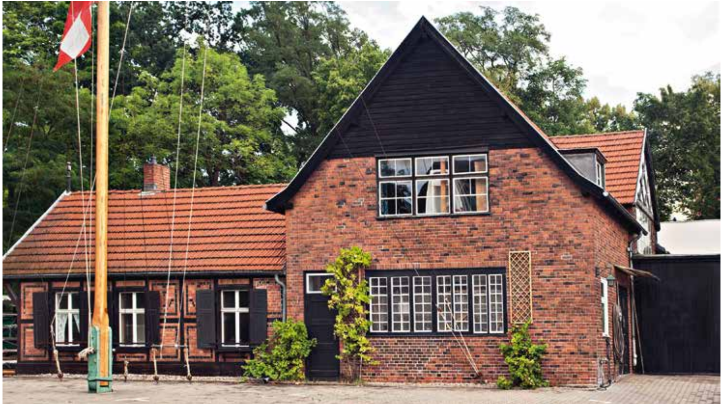
Der neue Giebel mit Anbau von der Hofseite her, nach dem Brand. Foto: 2012
